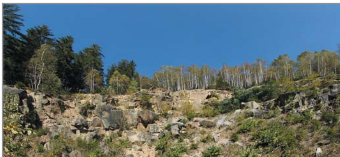
Lokalita 85 SK – Celkový pohľad na bývalý kameňolom
