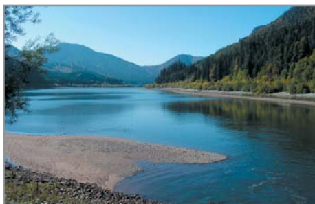
Lokalita 41 SK – Pohľad na dolnú vodnú nádrž z východu
